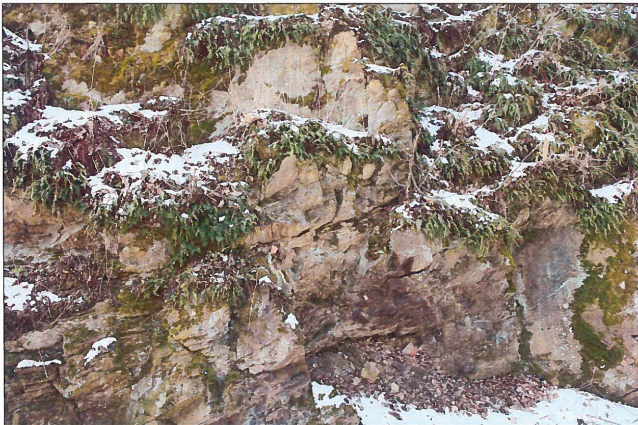
Foto – 8 Pohled vlevo v km 31,110 na rozvolněnou horninu v převisu.
