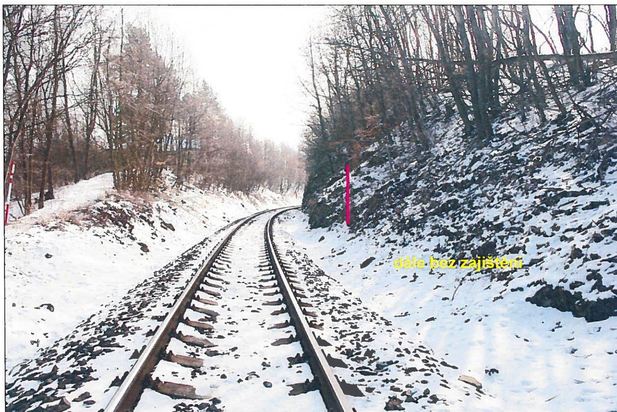
Foto – 9 Pohled do zářezu k Uničovu (proti staničení) v km 31,160. Svislá čára ukazuje na konec nutného zajištění.
