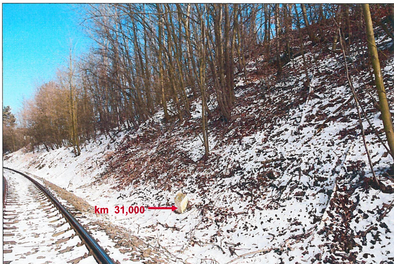
Foto – 2 Pohled do zářezu k Šumperku z km 31,000 vpravo. Svah je pozvolný a patrně zasucený se vzrostlými stromy v celém úseku zářezu.
