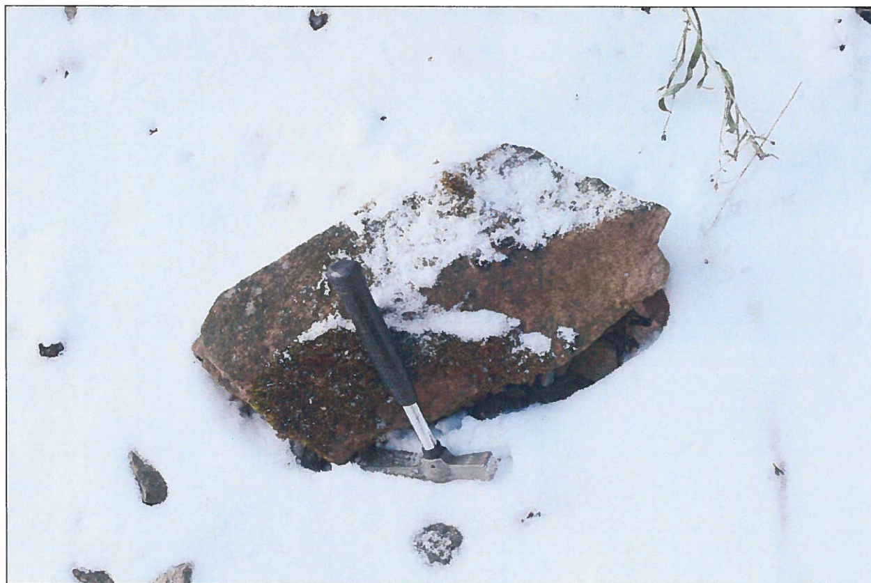
Foto – 7 Pohled vlevo 31,105 na vypadlý fragment velikosti cca 60 cm mezi patou svahu a krajním kolejovým pasem.
